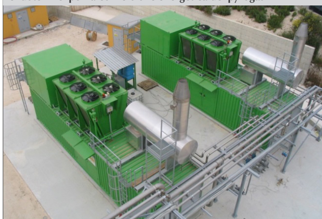
Fig. 4 - Impianto di pirolisi su scala industriale e motori endotermici per la conversione energetica del pyrogas
