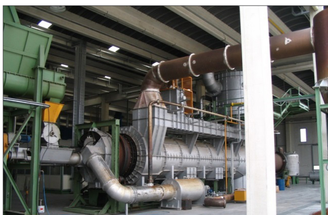
Fig. 4 - Impianto di pirolisi su scala industriale e motori endotermici per la conversione energetica del pyrogas
