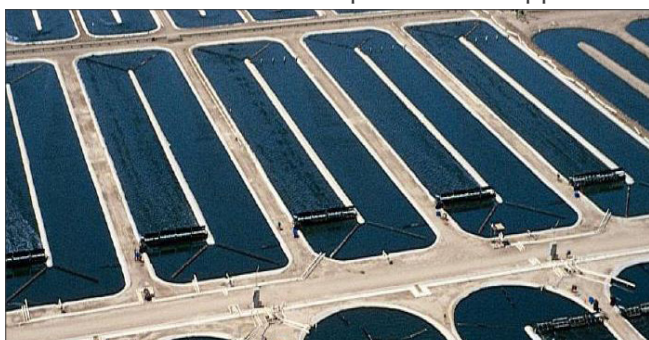
Fig. 13 - Impianti di accrescimento algale di tipo open pond
